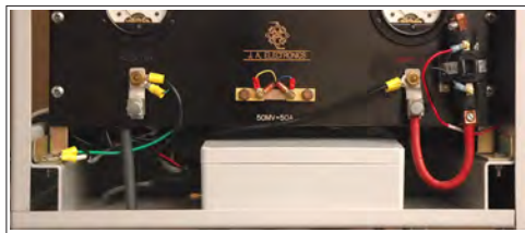
RM4015 Placement Inside Rectifier
